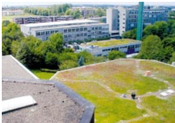
Kontrast: Das bepflanzte Mensadach hebt sich deutlich vom tristen Dach des Nachbargebäudes ab.
