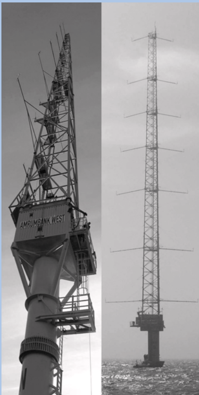
Messmasten zur Standortbestimmung von Offshore-Windenergieparks. Links: Standort Nordsee, Rechts: Standort Ostsee. Die beiden ca. 95m hohen Messmasten bilden die Datengrundlage für drei Offshore-Windparks mit 360 WKA der 4-5 MW Klasse.
